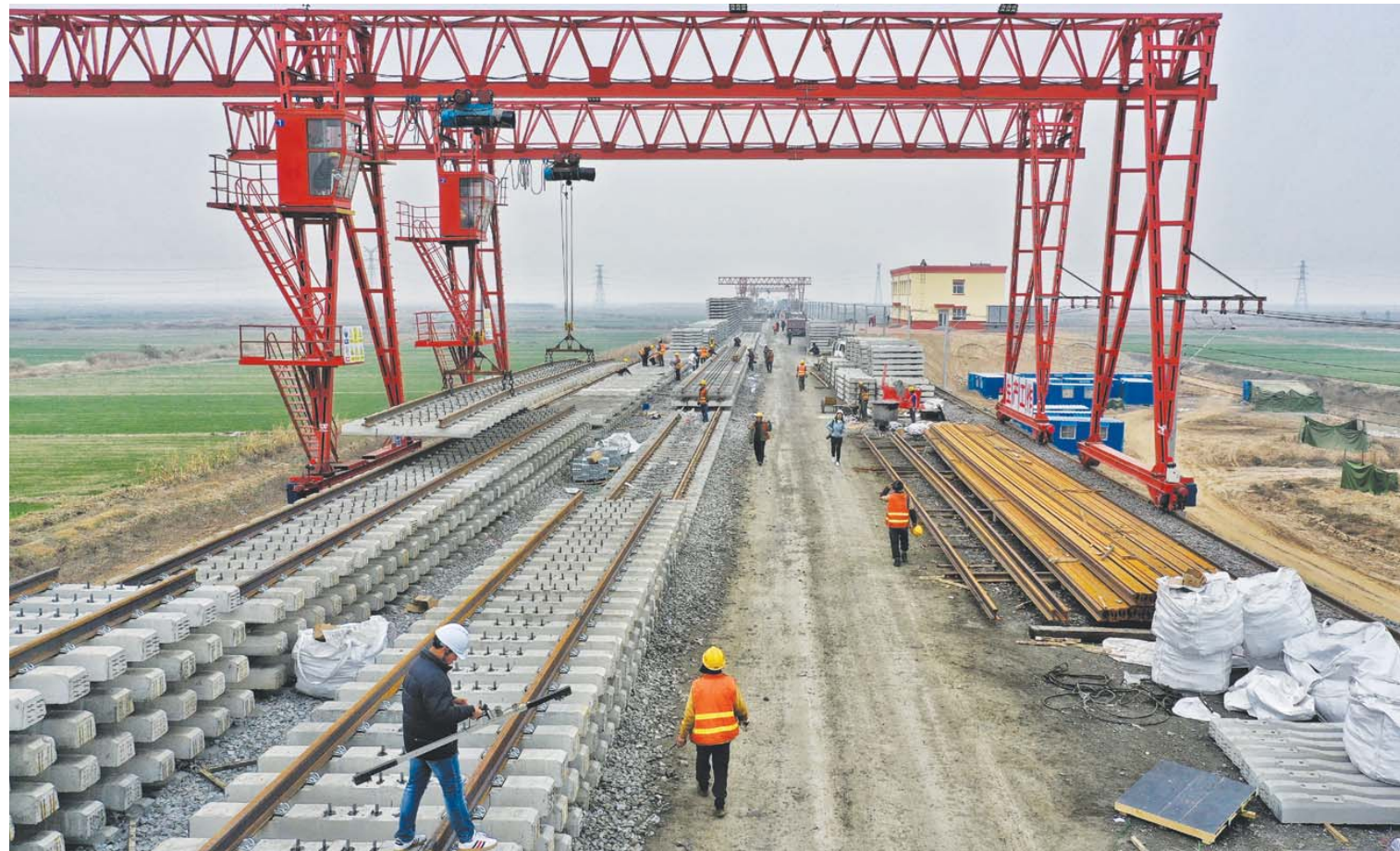
疏港铁路铺轨施工有序进行
