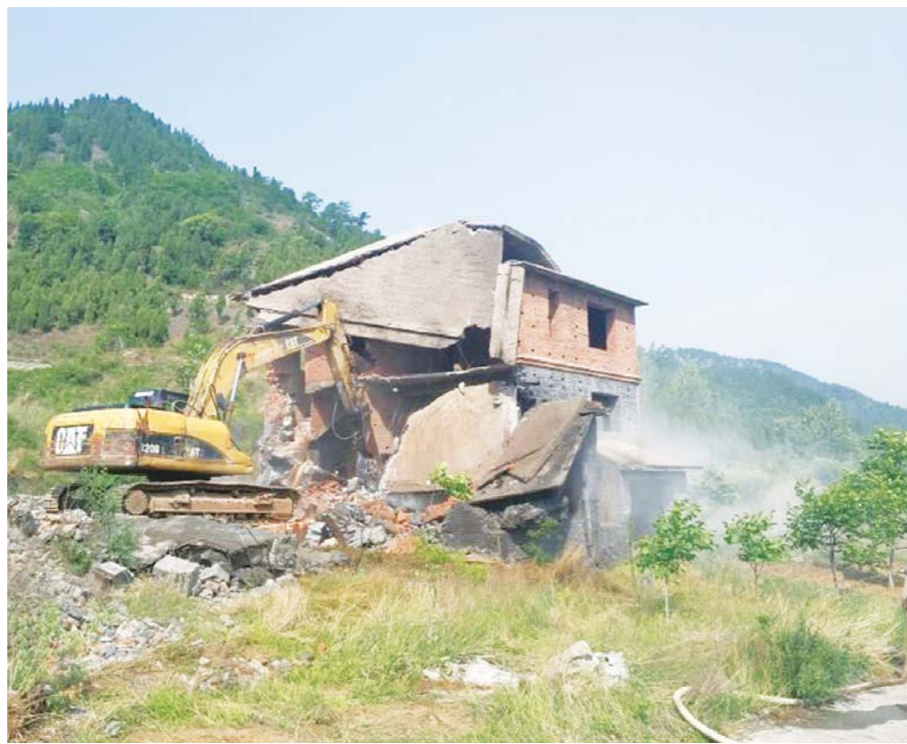
高而办事处拆违拆临现场。(资料片)
