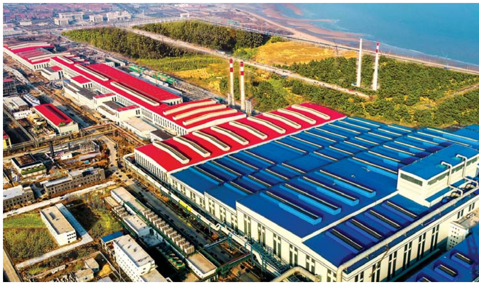
日照山钢基地厂区全景——尾气发电工程。
