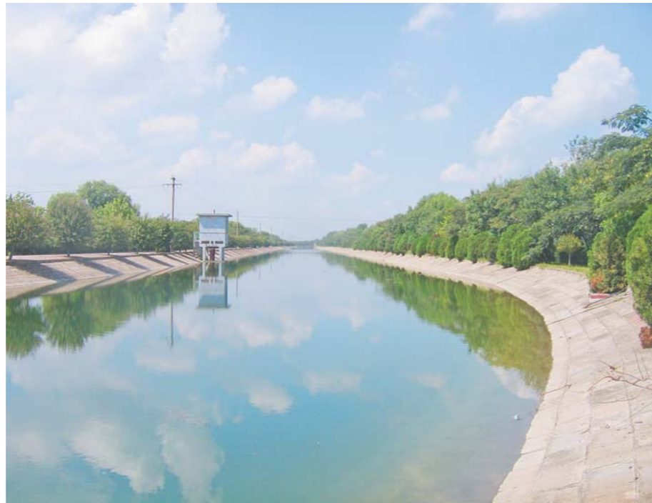
图为引黄济青输水渠道。
