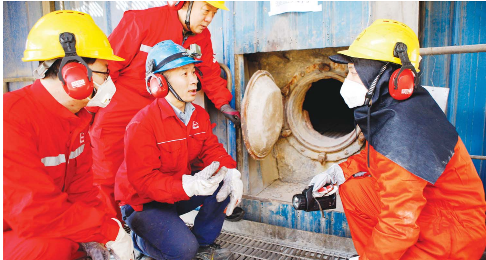
胜利油田胜利发电厂工人们在认真学习交流，以便熟练掌握操作技能，保证检修工作顺利完成。
