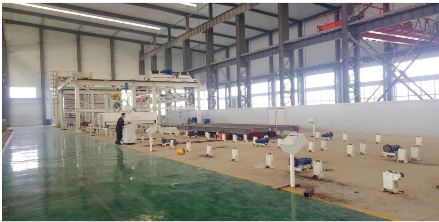
山东鸿琨住工科技有限公司工业化住宅PC预制构件建设项目生产线已经全面建设完成，工人正在调试设备。
