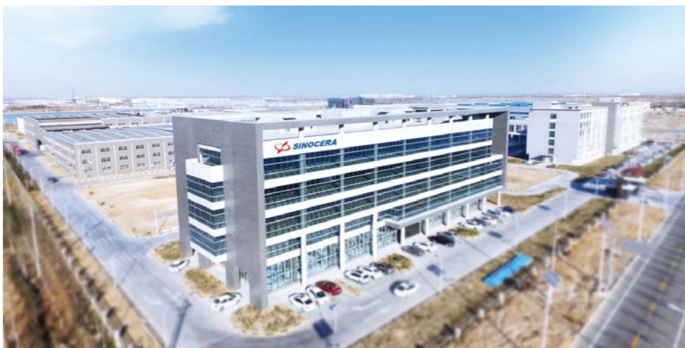
东营经济技术开发区国瓷公司一角。
