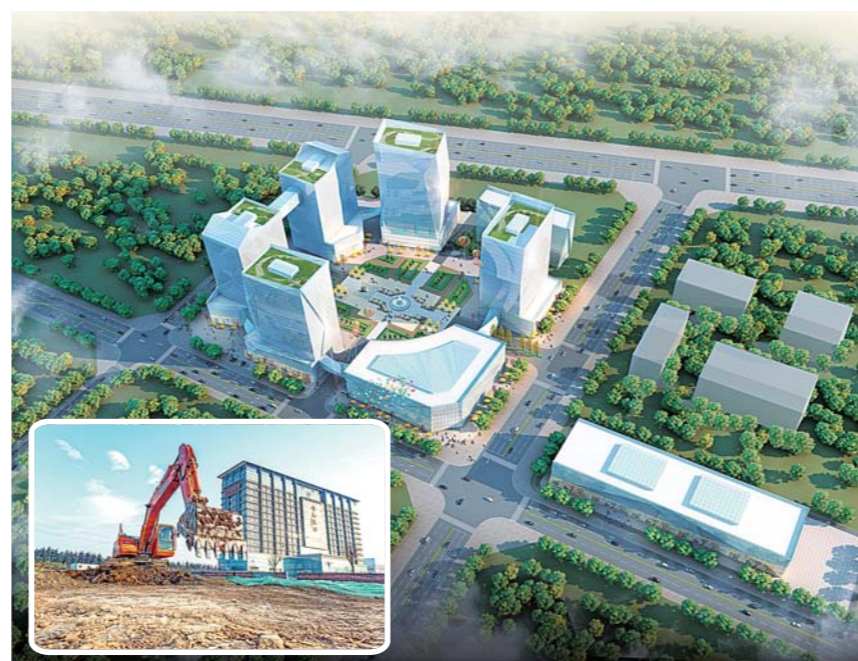
大图为山东爱特云翔IDC大数据中心产业园效果图,小图为项目施工现场。
