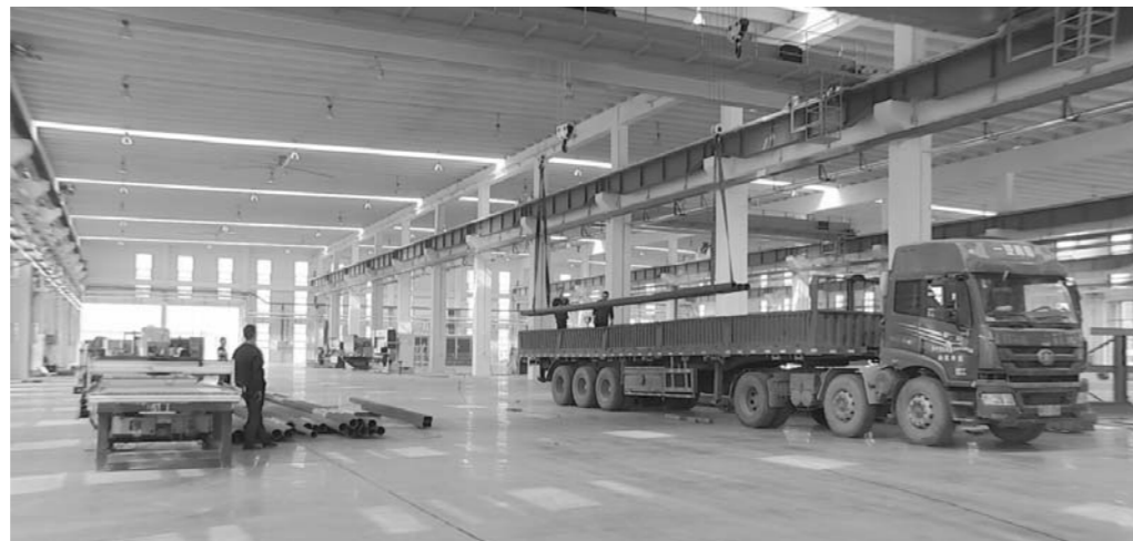
□石如宽 戴玉亮 报道 寿光北航新材料产业园项目现场,大型机械在吊装设备。项目全部达产后,预计年可实现产值60亿元,利税5亿元。
