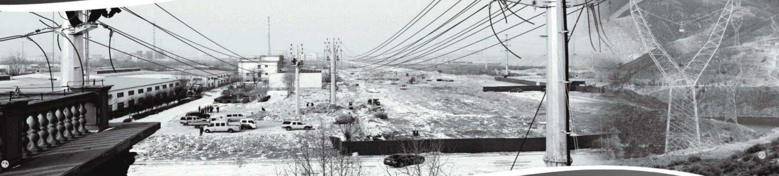
⑤山西500千伏府忻铁路工程施工现场
