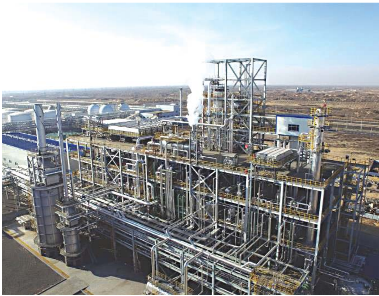
位于陕西榆林的兖矿集团未来能源10万吨/年高温费托合成工业化示范装置
