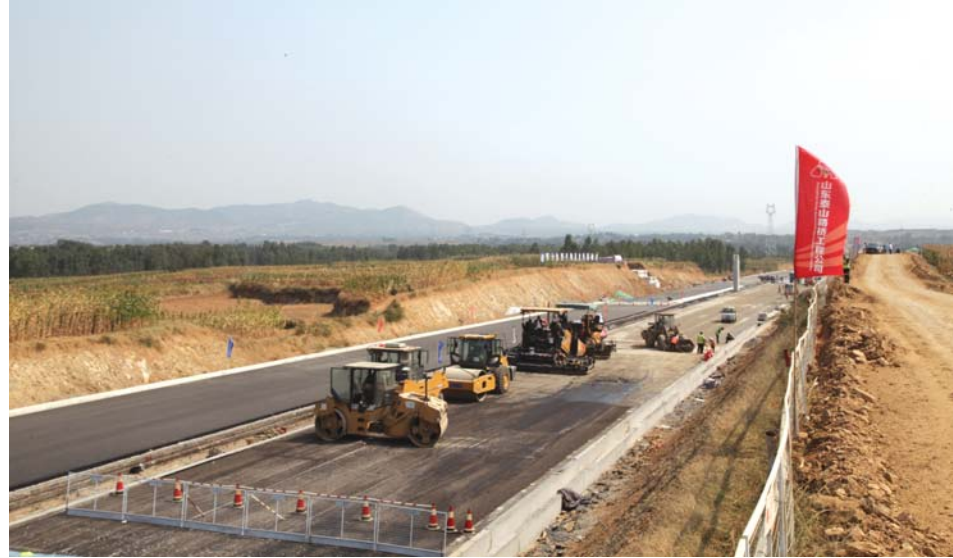
董梁高速新泰至宁阳段项目施工现场。
