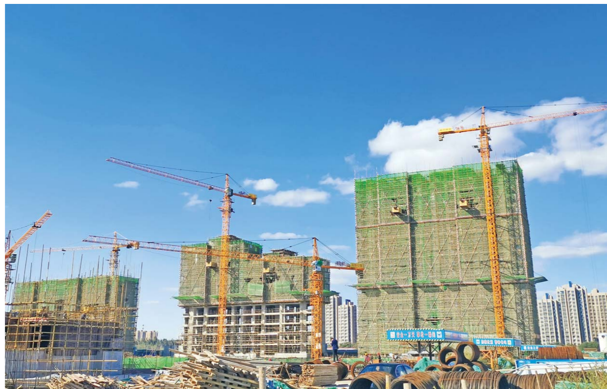
▲潍城区万特公馆项目建设现场。
