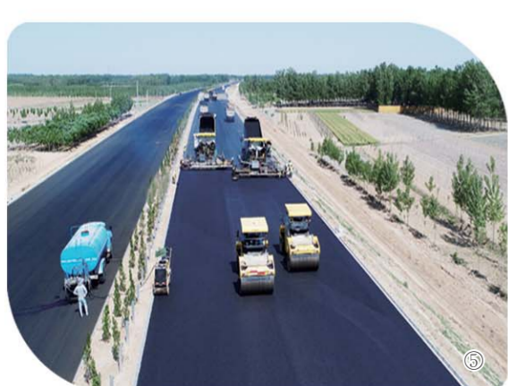
①李海务互通立交 ②青兰高速鲁冀交界处 ③跨京九铁路特大桥 ④南水北调干渠钢箱梁桥 ⑤沥青路面摊铺
