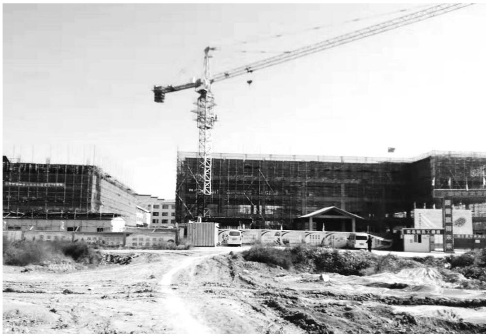
图为桐山书苑颐养院项目建设施工现场。
