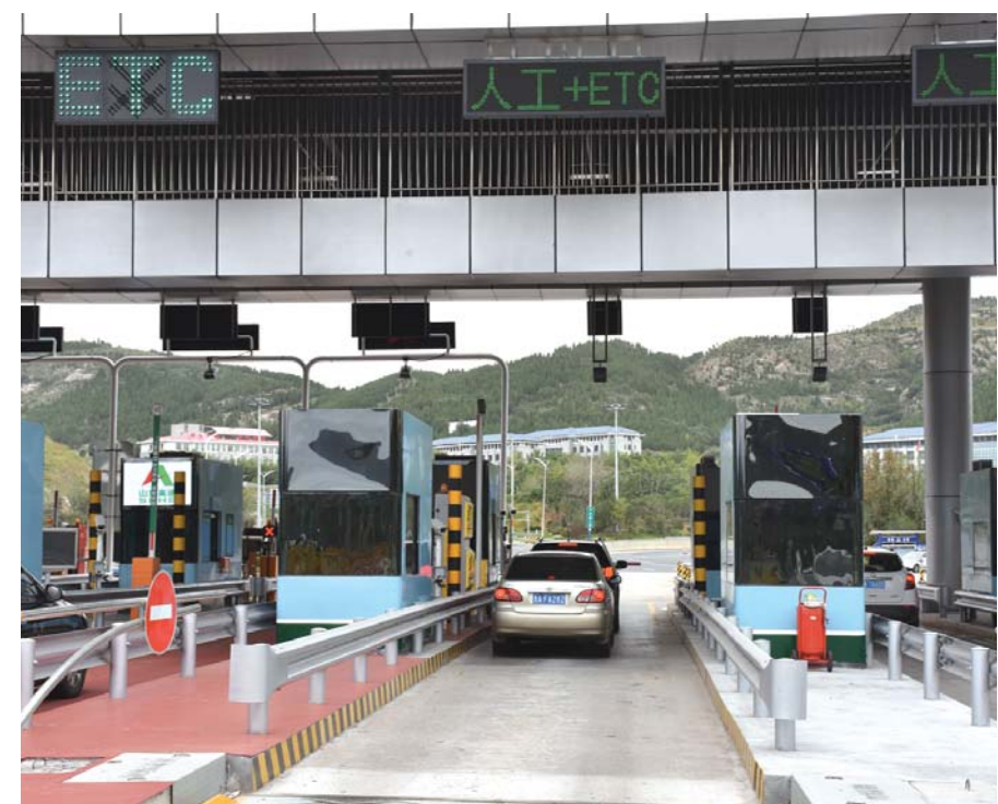
ETC车道升级改造完成。
