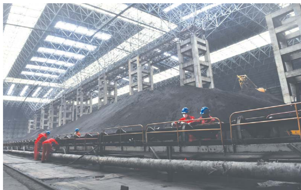
胜利发电厂煤场封闭工程。
