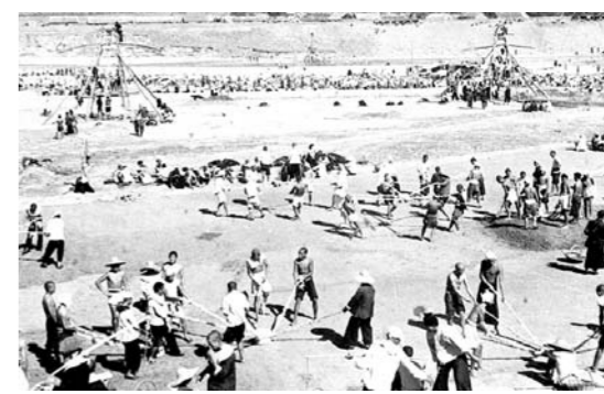
△治理淮河的第二期工程中，民工在河南省泌阳县板桥水库工地施工(资料照片)。
