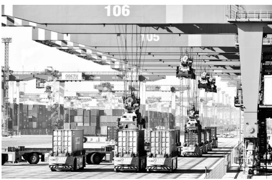
青岛港全自动化集装箱码头正在作业。
