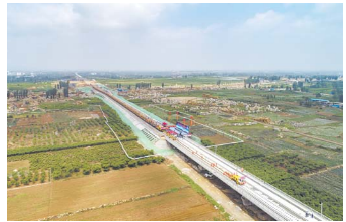
鲁南高铁建设正加速推进, 预计2019年底建成通车。(资料图)
