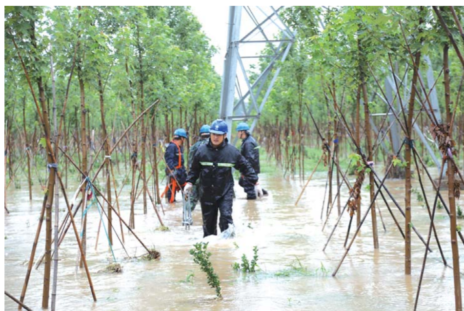
国网临朐县供电公司抢修人员对倾斜的铁塔进行拉线紧固。
