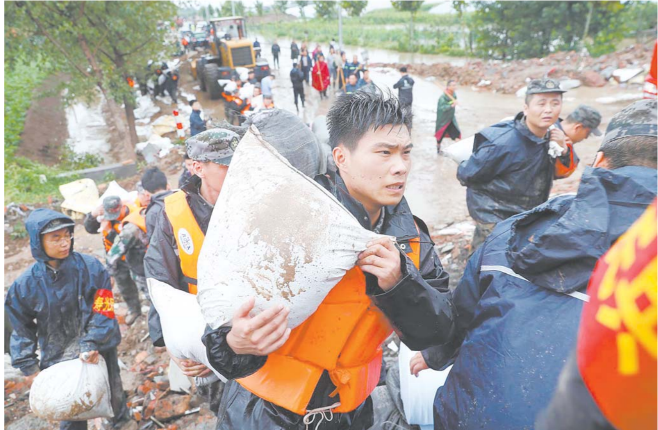
11日下午,寿光市洛城街道南官庄村丹河河堤出现险情,近200名部队官兵和消防队员赶到现场,加固河堤,消除隐患。
