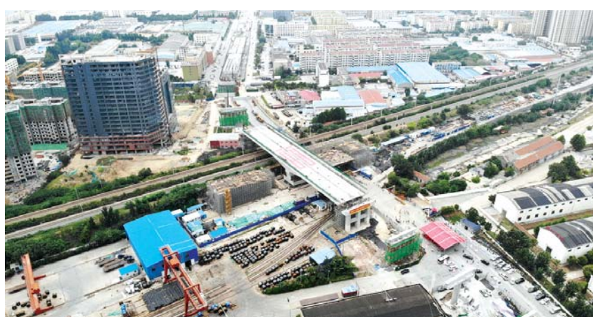
火炬路跨线桥转体梁成功完成“空中转体”，与南北两侧的桥墩完美对接。
