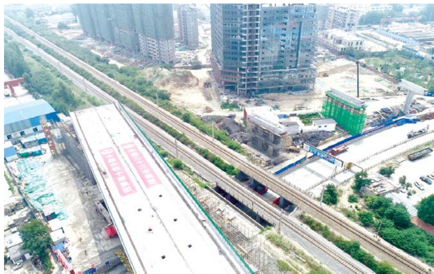
火炬路跨线桥转体梁正在“空中转体”。
