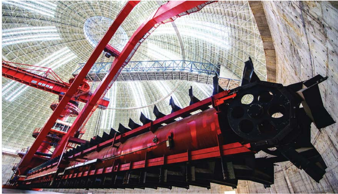
兖矿陕西未来能源煤制油项目直径110米的圆形料仓。
