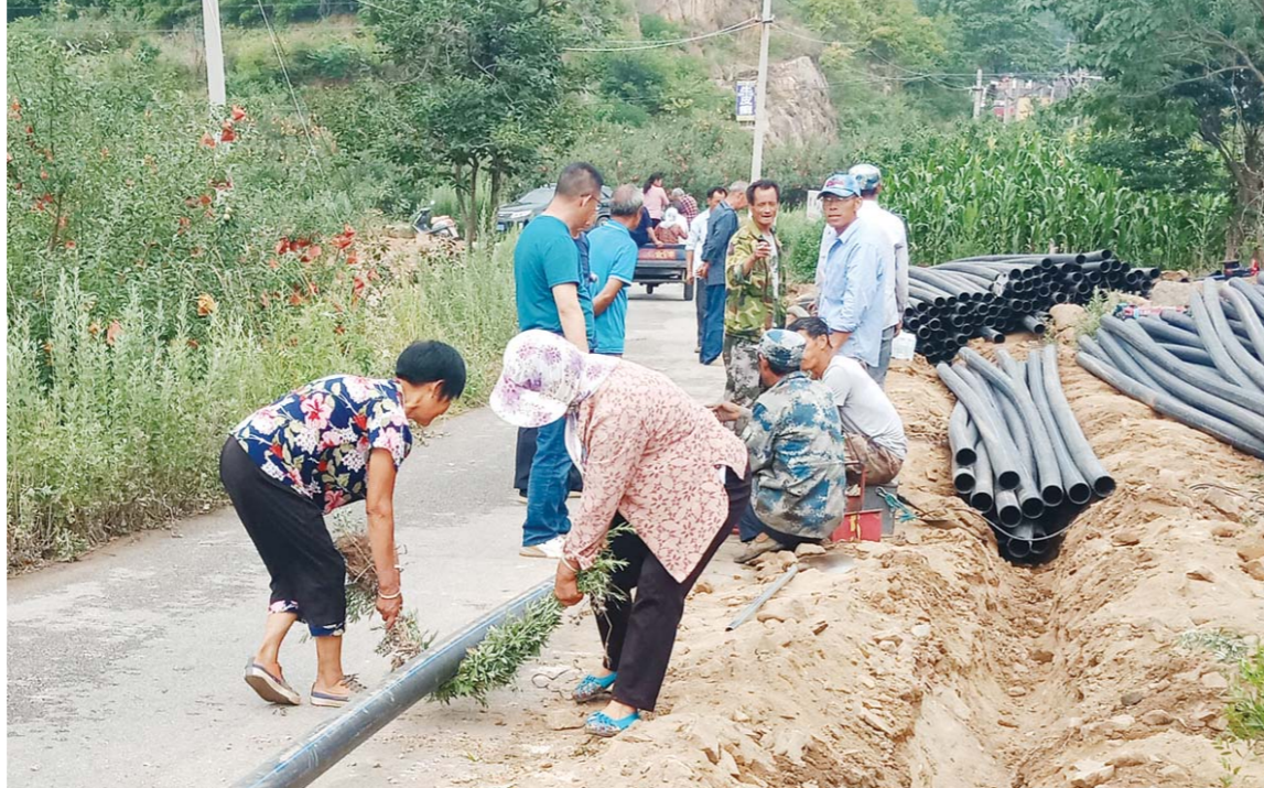
□ 梁海超 孙清华 报道 日前，烟台地区持续高温干旱，全市上下不等不靠，迅速行动起来，把抗旱救灾作为当前农业生产首要任务。栖霞市庙后镇黑芥村全体村民在村党支部的带领下，先后集体投入10多万元，建设完成全长将近1.5公里的村下游转输水渠工程，完成引水抗旱、灌溉果园保丰收。图为村民将输水管道铺设进果园。
