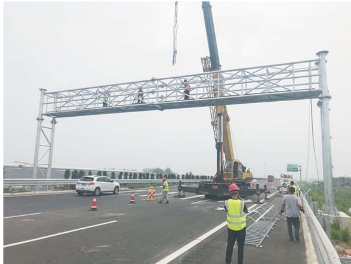
□记者 常青 报道 青银高速K164处ETC门架吊装施工现场。
