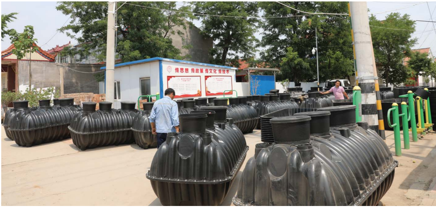
寿光市圣城街道,农村旱厕改造现场。
