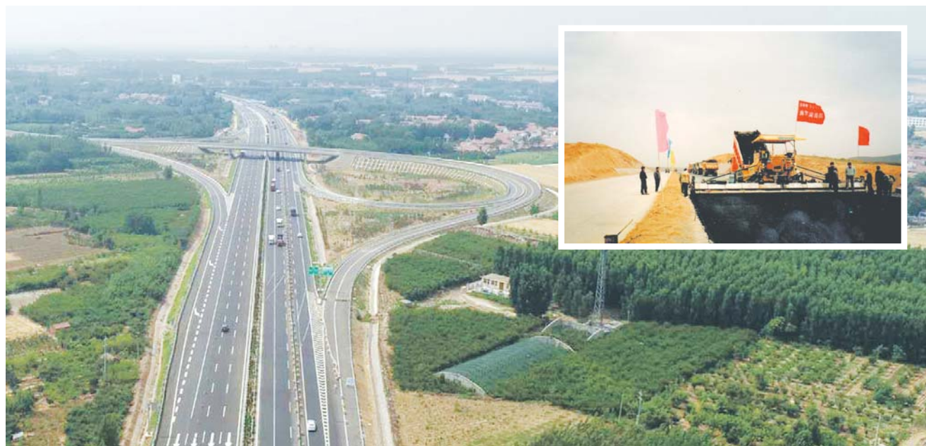
大图:俯瞰济青高速改扩建工程邹平西互通立交。小图:1992年,济青高速潍坊段施工现场。(资料图)
