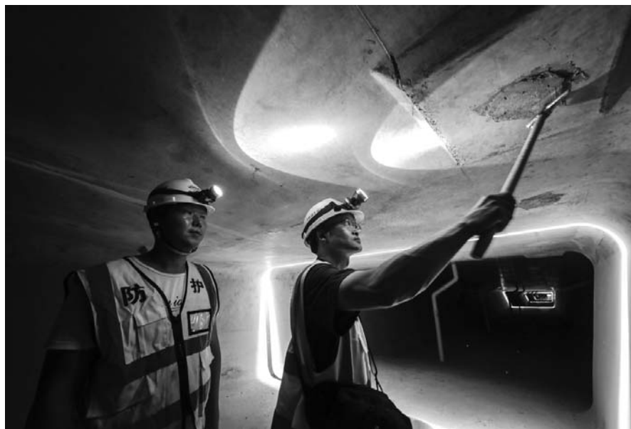
在梁箱内，李海波(右)正在对内壁进行检测。
