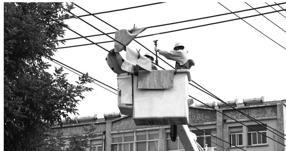
图为莒南供电员工在开展带电作业。
