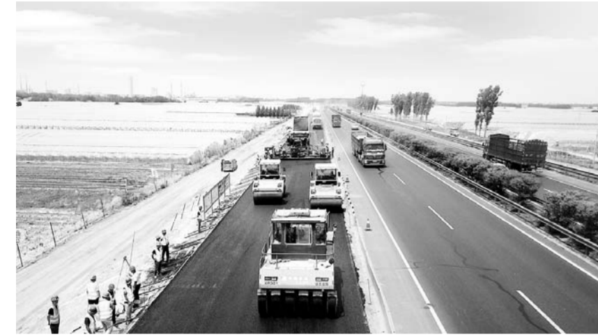
△济青高速公路改扩建工程踪影
