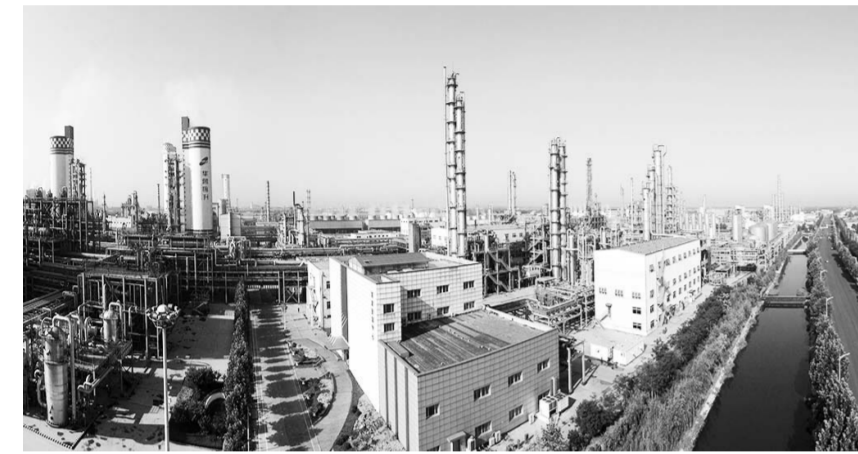
△华鲁集团绿色化工新材料园区一角
