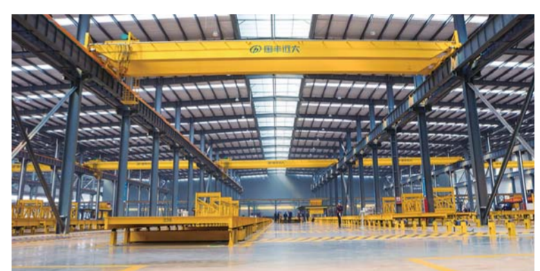
△国丰远大装配式建筑产业基地项目
