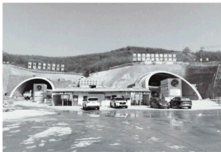
△文莱高速中庄隧道
