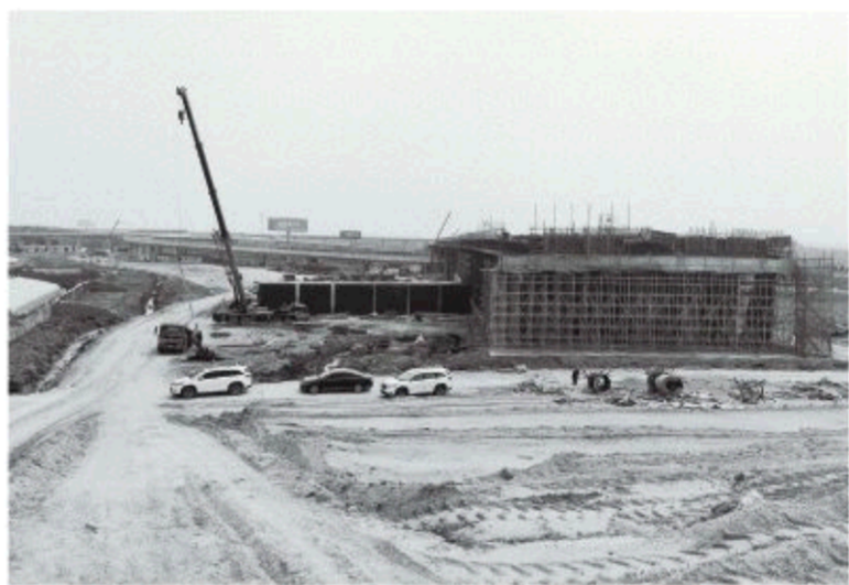
△文莱高速莱村西枢纽互通立交
