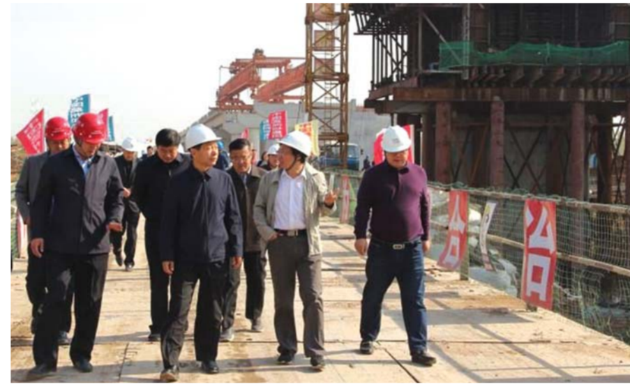
京台高速公路南四湖特大桥施工现场。
