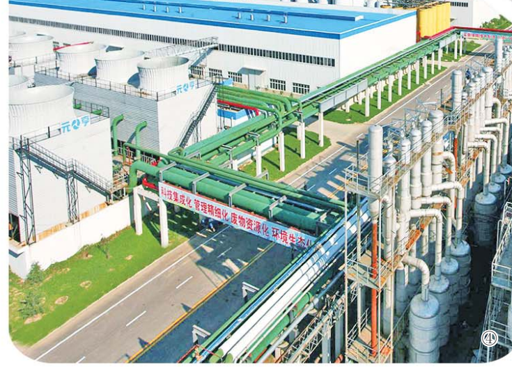
③发酵车间控制室 ④梁山菱花生态工业园厂区一角
