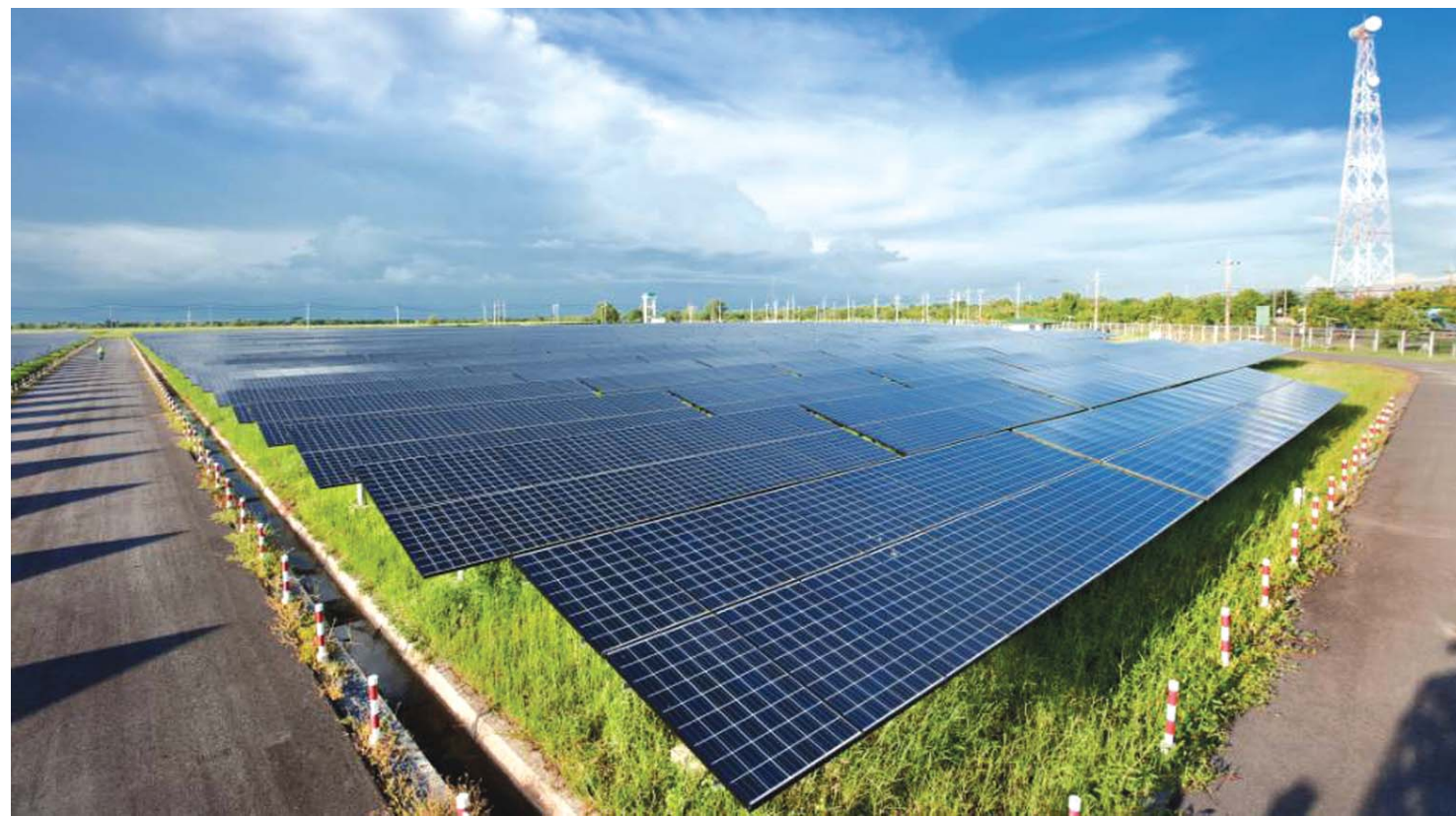
光伏发电项目现场。
