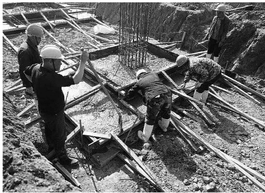
4月11日，临清烟店智造小镇项目工人正在施工中。
