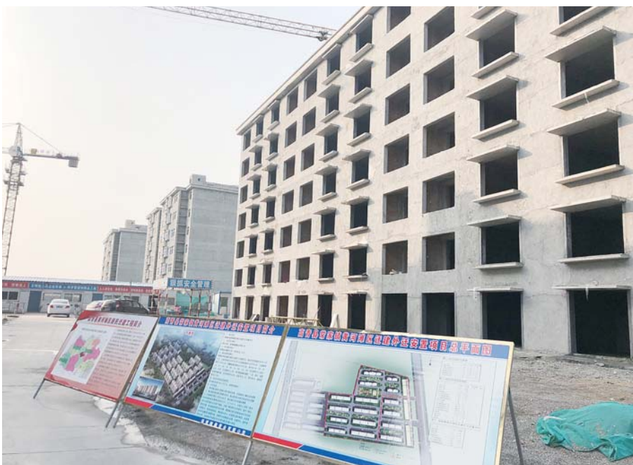
□记者 杜文景 通讯员 杨萍萍 报道 在高青县常家镇黄河滩区迁建外迁安置项目建设现场,规划的12栋安置楼房已全部封顶,工程完工后,可安置滩区群众1050人。
