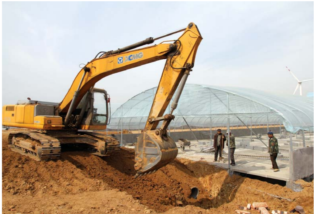
一台挖掘机正在深挖沟渠，准备填埋封闭式管道。正在建设中的养殖棚4月份就可以引进仔猪了。
