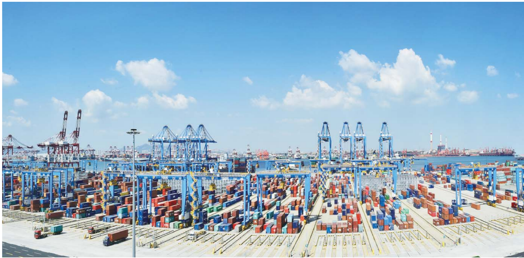
青岛港正在成为对外开放、“一带一路”重要的节点，成为青岛、山东乃至中国连通世界的接口。图为青岛港前湾港区俯瞰。
