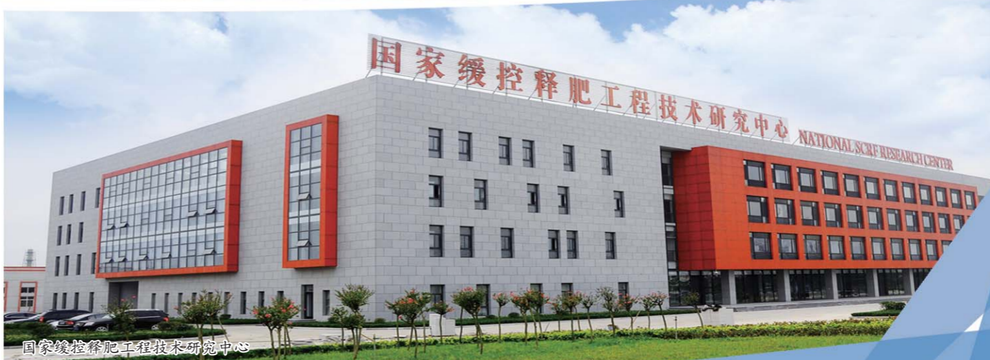
国家缓控释肥工程技术研究中心
