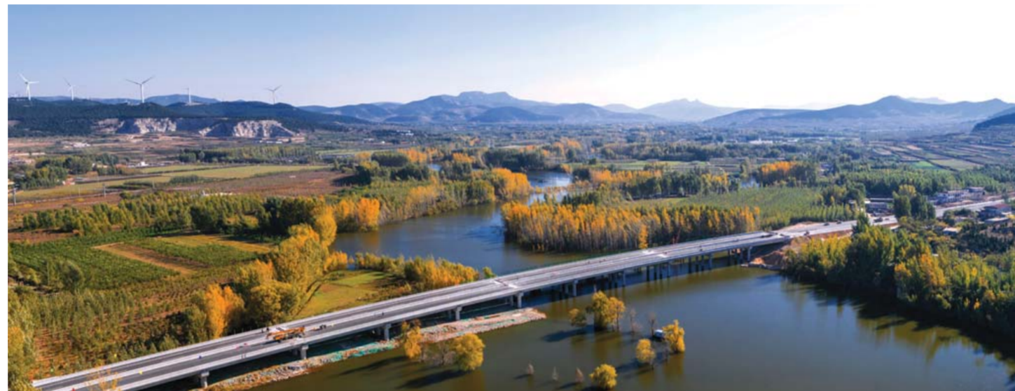
G220平阴南段公路项目关键性节点工程浪溪河大桥。
