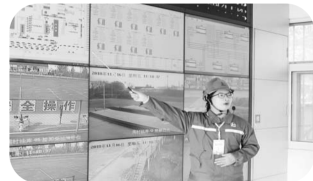
△淄博公司周村油库中控室讲解油库自动化设备
