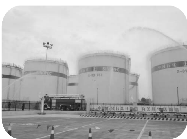
△德州公司油库开展联合消防演练
