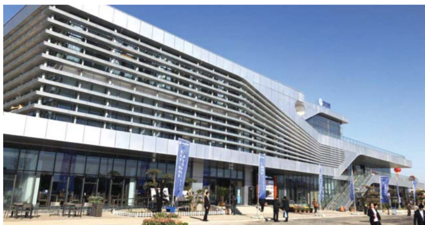
重建后的长清服务区主楼。
