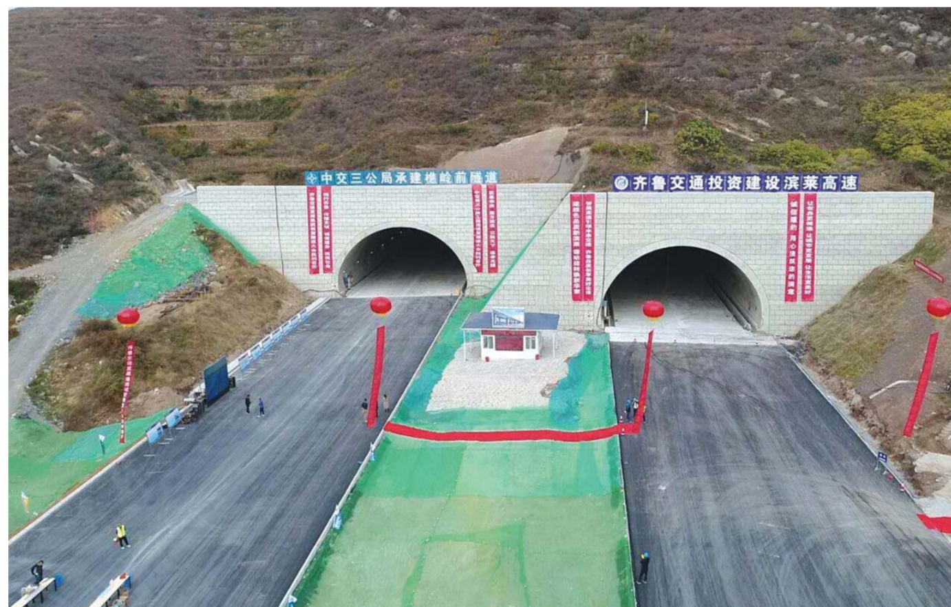
滨莱高速公路改扩建工程嵇岭前隧道。
