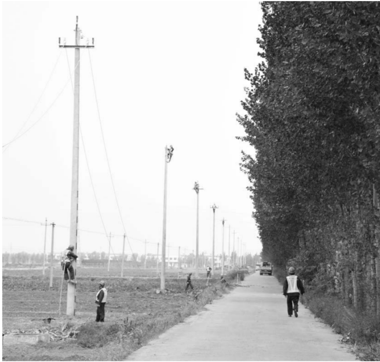
△为确保县重点项目伊利集团依然牧业早日投产，10月12日，国网平阴县供电公司60余名施工人员全力奋战在新建线路工程现场架设导线。(张立伟)
