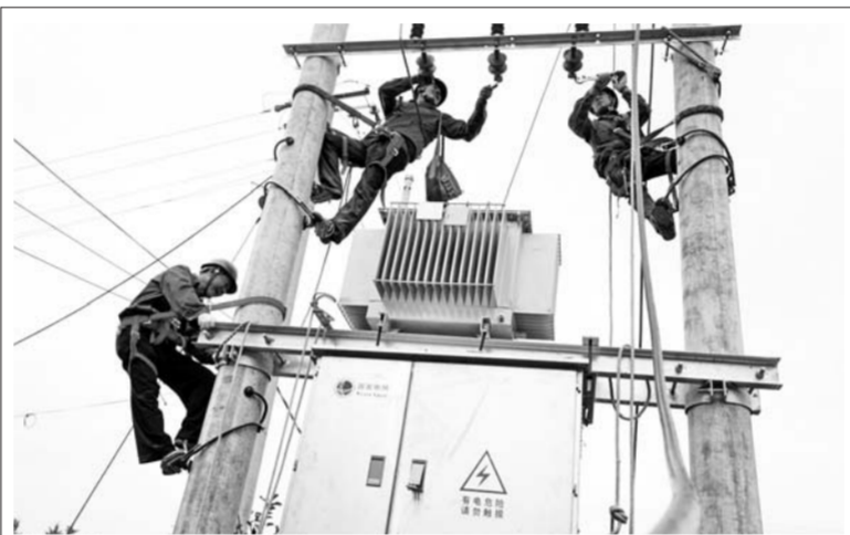
为保证秋收秋种期间的用电，国网栖霞县供电公司部分线路进行升级改造。图为10月8日，工作人员在栖霞县下苇城村进行作业。（任梦雪）
