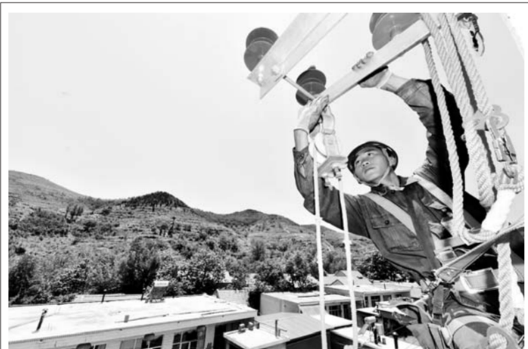
淄博供电公司施工人员为沂源县鲁村镇北流水村架设新的0.4千伏线路，为乡村脱贫致富提供充足的电能。（远德亮）
