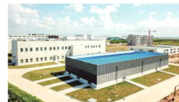
△正在建设的润辉生物科技项目
