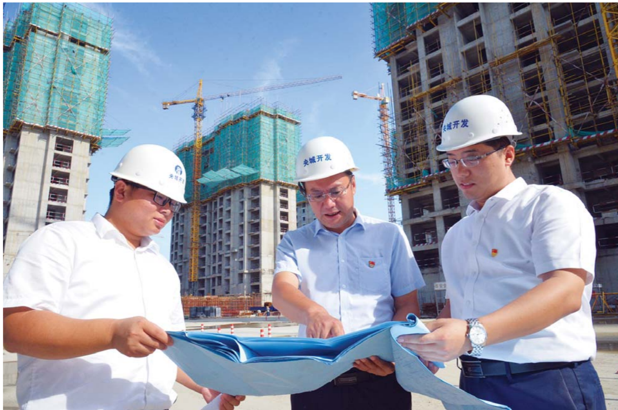
潍坊滨海区重点项目每天都有工作人员靠在一边,现场协调解决相关问题。图为刘邦锋(中)韩伟(右)在潍坊滨海区中央城区央城·汇景湾项目了解项目进度。
