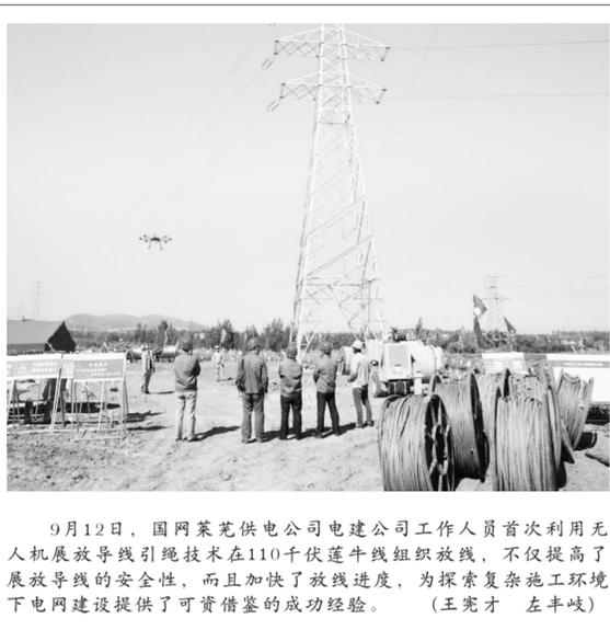
9月12日，国网莱芜供电公司电建公司工作人员首次利用无人机展放导线引绳技术在110千伏莲牛线组织放线，不仅提高了展放导线的安全性，而且加快了放线进度，为探索复杂施工环境下电网建设提供了可资借鉴的成功经验。(王完才 左丰岐)
