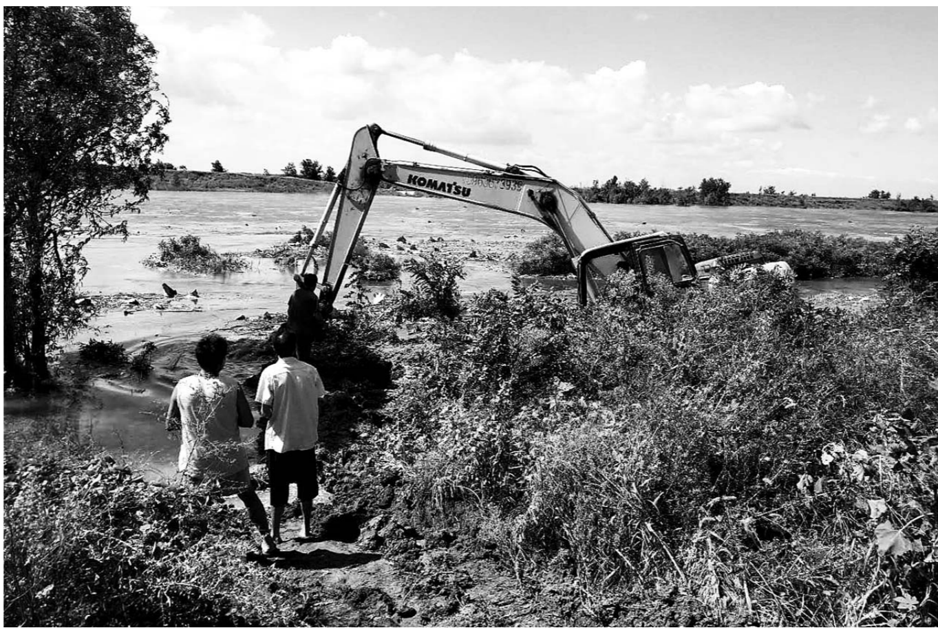
连日来，面对台风“温比亚”带来的暴雨天气给当地造成的损害，寒亭区各部门奋力抢险救灾，确保将损失降到最低。图为堤街道组织人员、机械对危险区域加固清障。
